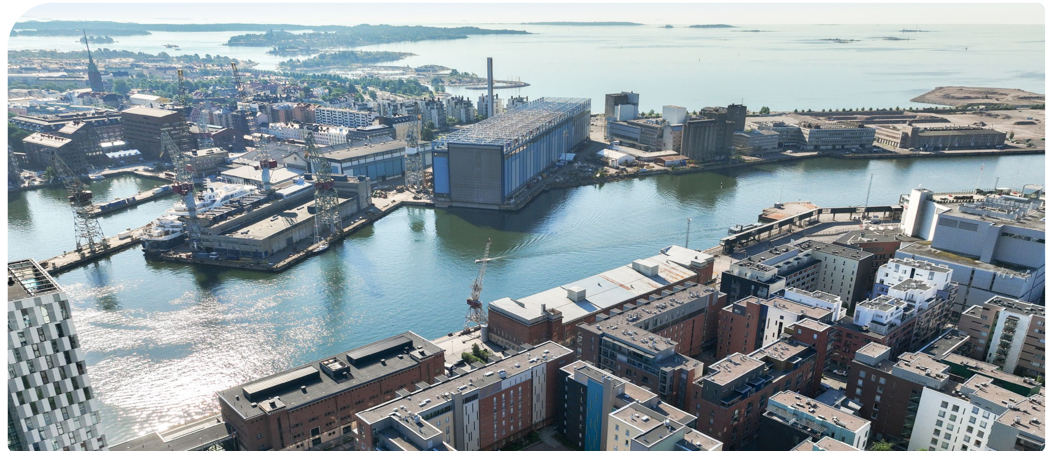
Suezinkatu 3, Helsinki (kuvan keskiosassa alhaalla)
